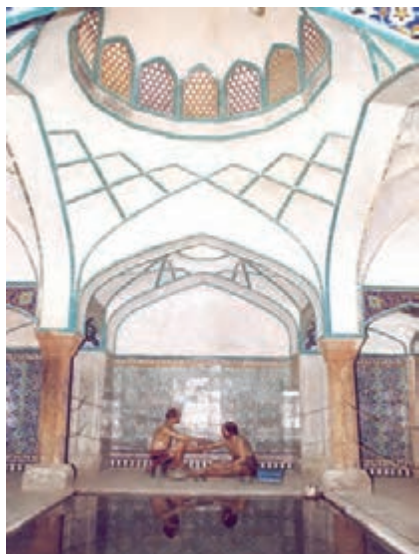
شکل ۲۰ - آهک‌بری در حمام گنجعلی خان کرمان
