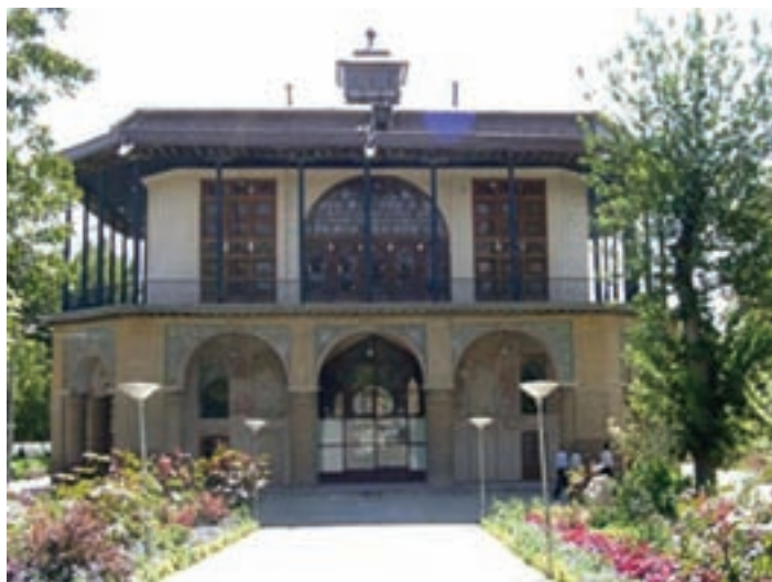
▲ شکل ۸-۱۲- عمارت چهلستون، قزوین
